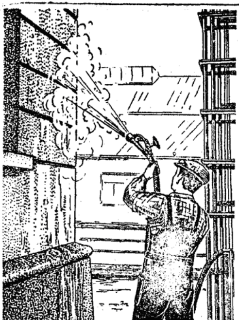
Рис. 2. Гидропескоструйная очистка фасада.
